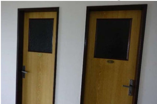
Soc. zařízení v admin. budově na st.p.č. 7/1
