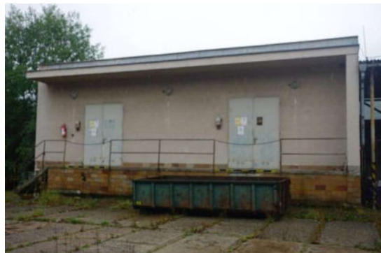
Sklad hořlavin na st.p.č. 109
